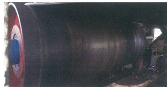
CV.108-A (Bend Pulley) No. 08
