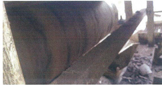
CV.109-B (Bend Pulley) No. 03
