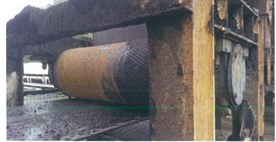
CV 105-B (Bend Pulley) No.06
